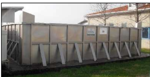
Figura 17: Biofiltro Syntal, E1
