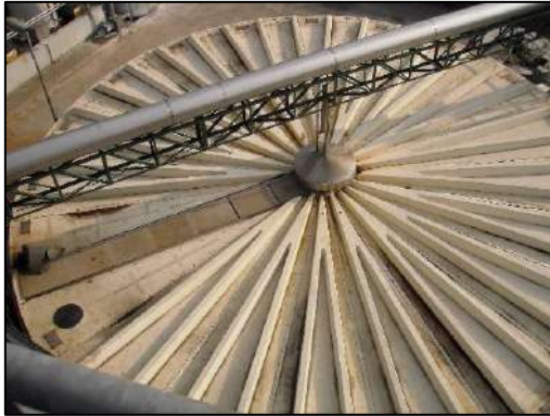
Figura 10: Sedimentatore primario
