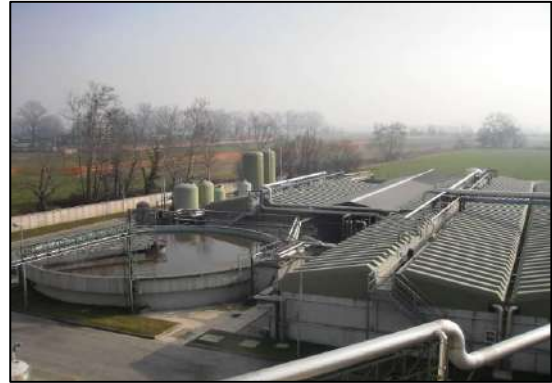
Figura 11: Comparto biologico e sedimentazione finale
