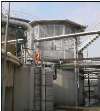
Figura 8: Sedimentatore chimico-fisico
