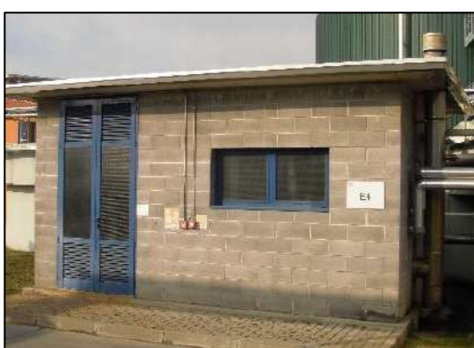
Figura 20: Locale caldaia, E4
