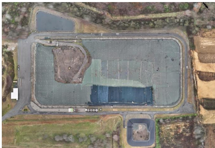
Figura 1: Visuale panoramica della cella 8 aggiornata al dicembre '25
