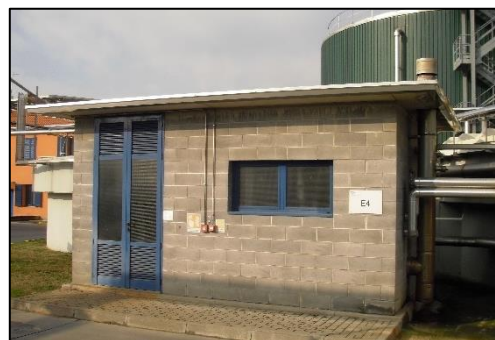
Figura 17: Locale caldaia, E4
