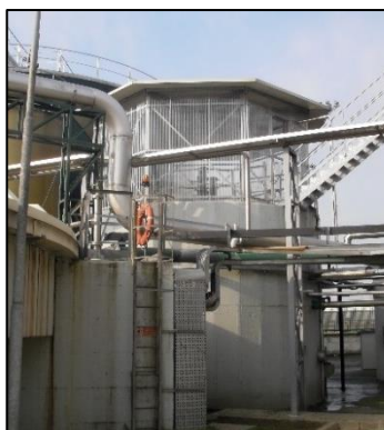
Figura 8: Sedimentatore chimico-fisico
