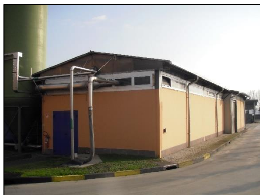
Figura 13: Locale filtropresse disidratazione fanghi biologici e chimici
