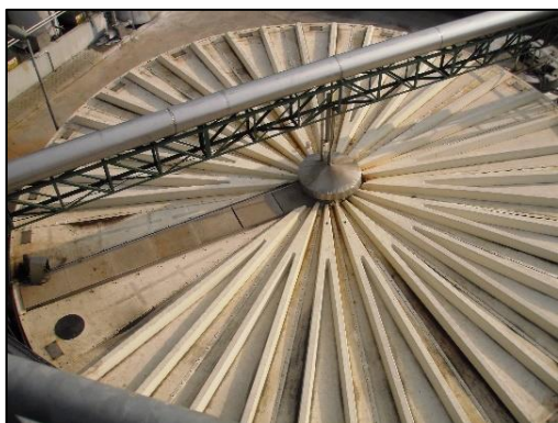
Figura 10: Sedimentatore primario
