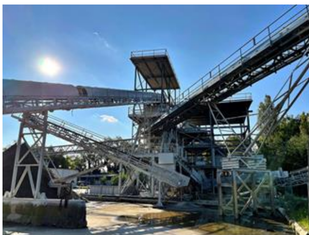
Figura 9 - Dettaglio Impianto di Soil Washing
