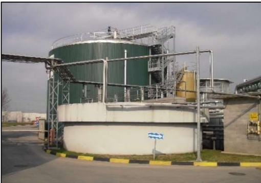
Figura 12: Ispessitore e digestore fanghi biologici
