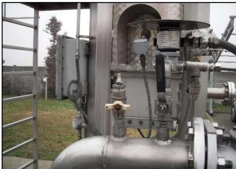
Figura 19: Beccuccio di prelievo del biogas
