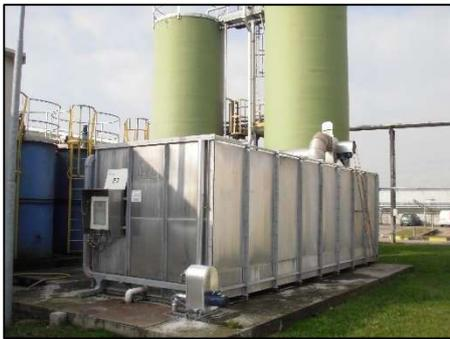
Figura 15: Biofiltro Air Clean E2
