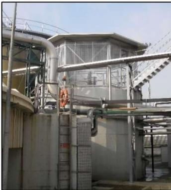
Figura 8: Sedimentatore chimico-fisico
