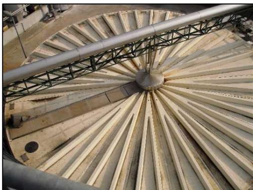
Figura 10: Sedimentatore primario
