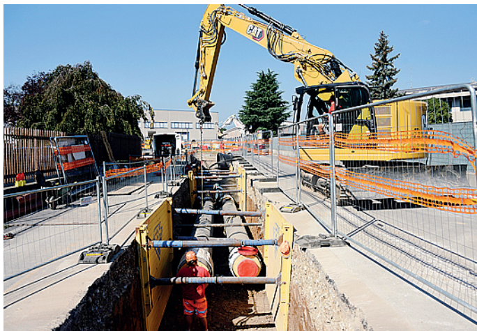
TRADALMINE ELALIO. Immagini del cantiere per i lavori di ampliamento della rete di teleriscaldamento. Le opere di posa delle tubazioni proseguono lungo la SP 525 Foto Bedolis
