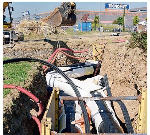
TRADALMINE ELALIO. Immagini del cantiere per i lavori di ampliamento della rete di teleriscaldamento. Le opere di posa delle tubazioni proseguono lungo la SP 525 Foto Bedolis
