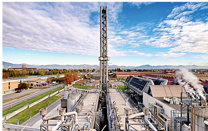
L'IMPIANTO Il termovalorizzatore Rea di Dalmine
