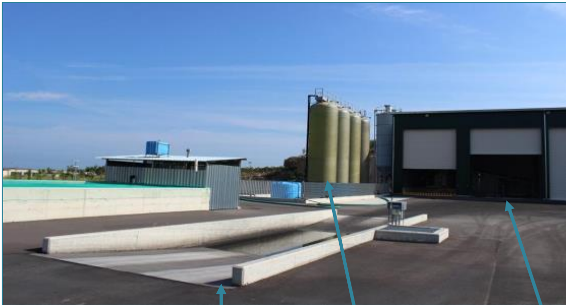
Fig. 5.4 – Alcune strutture di servizio: lavaggio ruote, serbatoi stoccaggio percolato, area trattamento rifiuti
