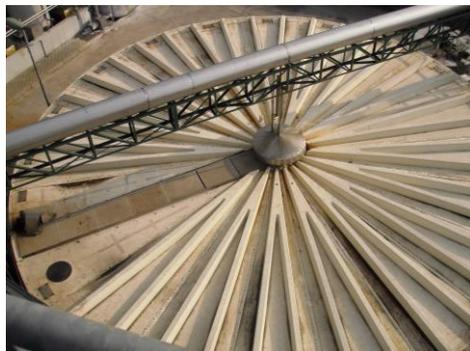
**Figura 10: Sedimentatore primario**
