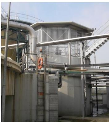
**Figura 8: Sedimentatore Chimico-fisico**
