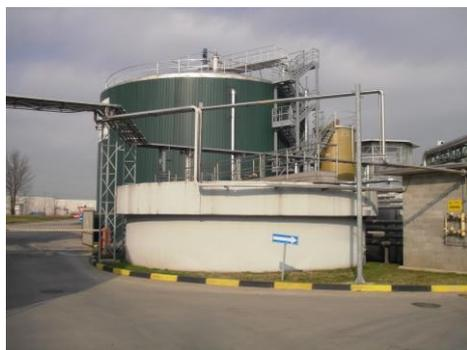
**Figura 12: Ispessitore e digestore fanghi biologici**
