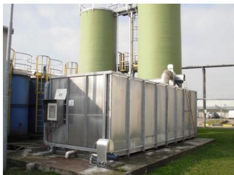
**Figura 15: Biofiltro Air Clean, E2**
