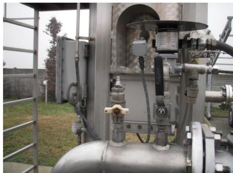
**Figura 19: Beccuccio di prelievo del biogas**
