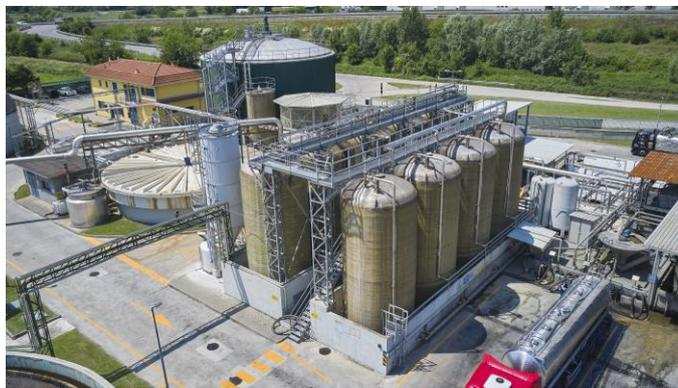
**Figura 9: Serbatoi di stoccaggio (reflui e reagenti)**
