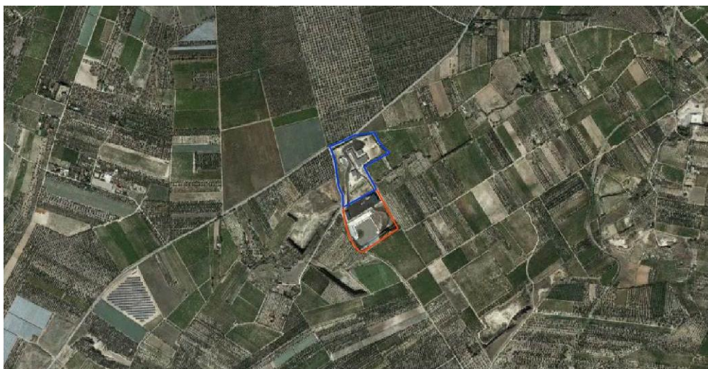
Fig. 4.1 - Inquadramento territoriale su ortofoto. Sono evidenziate in rosso le aree di impianto e in blu le aree di servizio.
