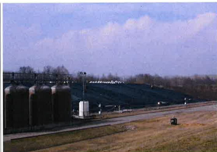
Figura 1: Scorcio della cella 8b con evidenza dei silos di raccolta percolato e della copertura provvisoria
