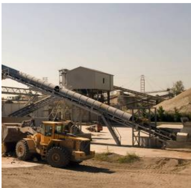
Figura 11: Impianto di chiarificazione di Eureko S.r.l.
