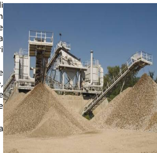
Figura 8: Vista dell’impianto recupero inerti di Eureko S.r.l.
