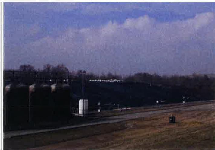
Figura 1: Scorcio della cella 8b con evidenza dei silos di raccolta percolato e della copertura provvisoria
