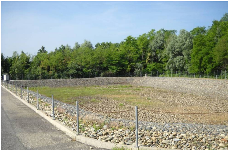
Figura 8: Vasca volano per acque meteoriche di ruscellamento
