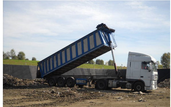
Figura 14: Scarico del rifiuto nella cella 8
