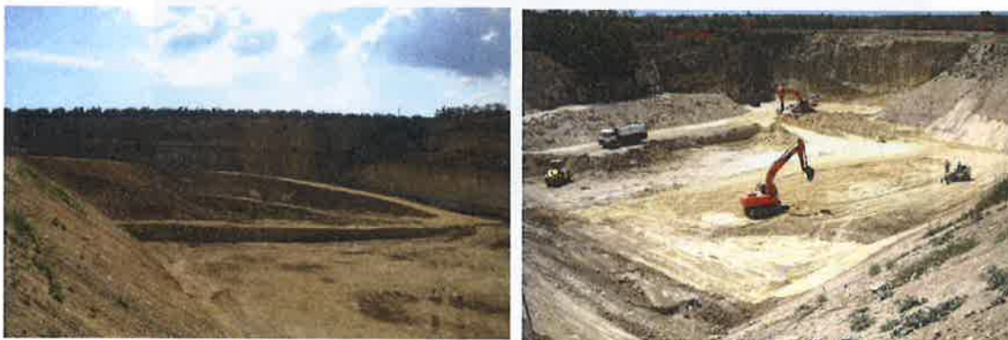
Fig. 4.2 – Area di cava abbandonata e primi lavori di impermeabilizzazione del bacino di discarica (08/2011).
