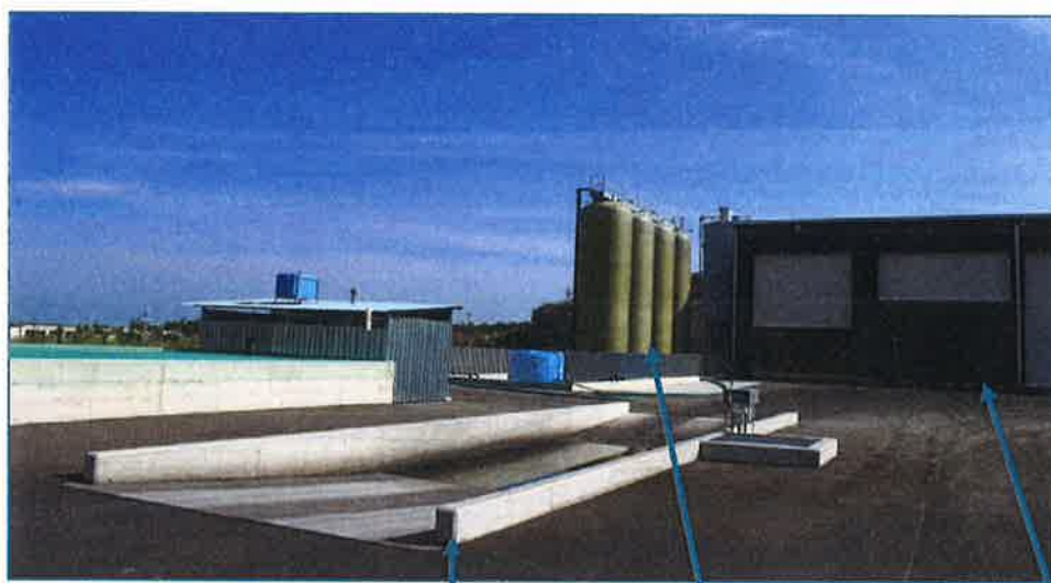
Fig. 5.4 – Alcune strutture di servizio: lavaggio ruote, serbatoi stoccaggio percolato, area trattamento rifiuti
