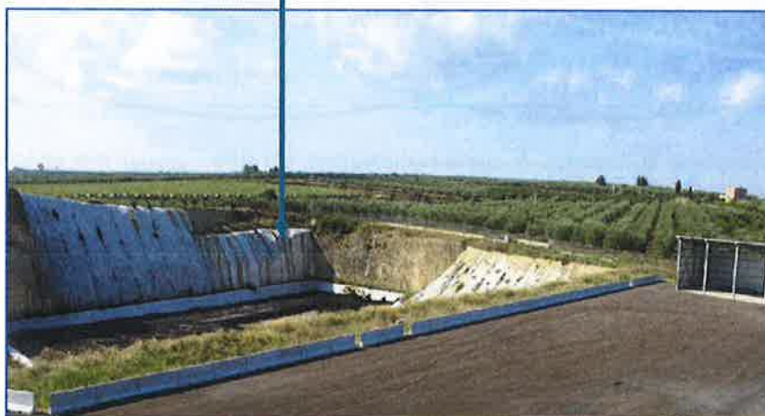
Fig. 5.2 – Porzione del bacino di discarica in coltivazione.
